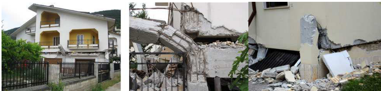
Figura_2 effetto dell'espulsione fuori piano di strutture collassate durante terremoto dell'Abruzzo.
