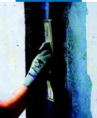
Rifinitura con frattazzino
